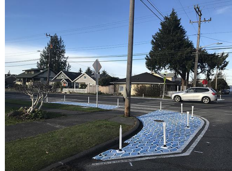
Εγκιβωτισμός στάθμευσης με διαπλάτυνση πεζοδρομίων στην Πτολεμαΐδα (αριστερά), εγκιβωτισμός στάθμευσης με κολωνάκια και βάψιμο οδού στην Αμερική (δεξιά)
