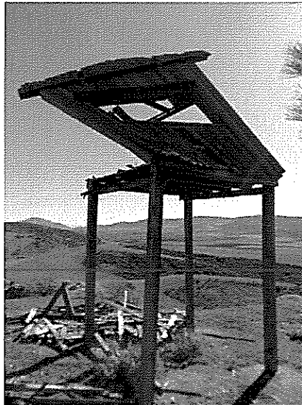
Εικόνα 10: Το κατεστραμμένο υπάρχον πυροφυλάκιο. Η καθαίρεσή του θεωρείται αναγκαία και για λόγους ασφαλείας
